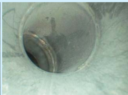
Schweissnaht in Wärmetauscher
